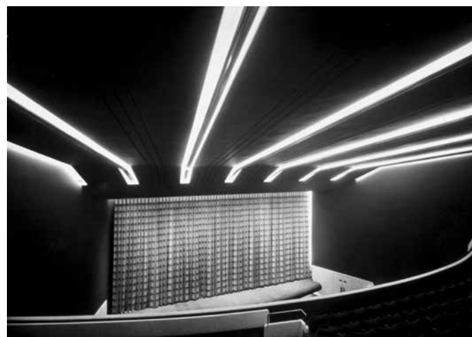
Die Dachstruktur wird aus grossen Aluminiumträgern gebildet, die gleichzeitig als Dekor dienen. Es ist die einzige Aluminiumstruktur dieser Bedeutung in der Schweiz.
